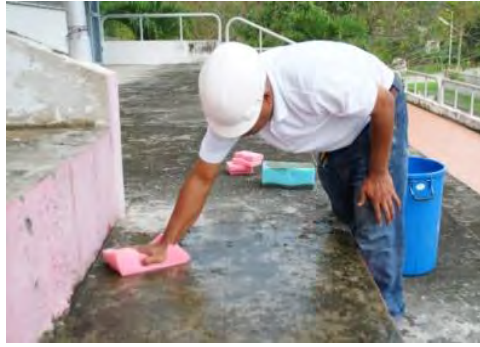
รูปที่ 14 การพ่นน้ำหรือสารละลายคอปเปอร์ซัลเฟต และเซ็ดละอองน้ำ
