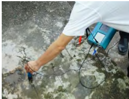
รูปที่ 21 การวางหัววัดบนจุดที่กำหนดไว้
